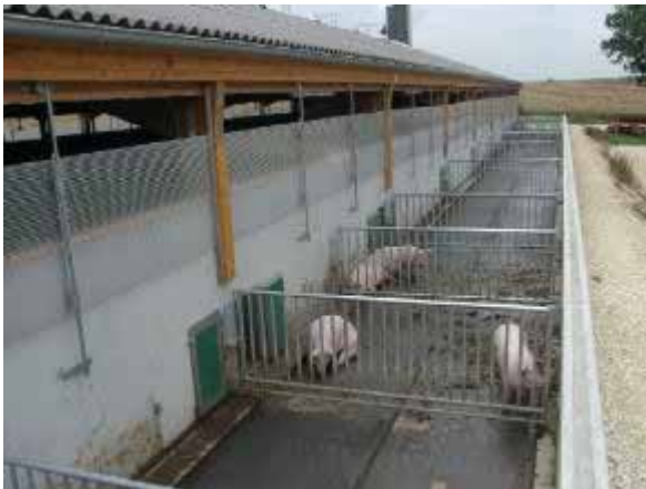
Betrieb 5: Auslauf planbefestigt, Klappschieber zur Entmistung
